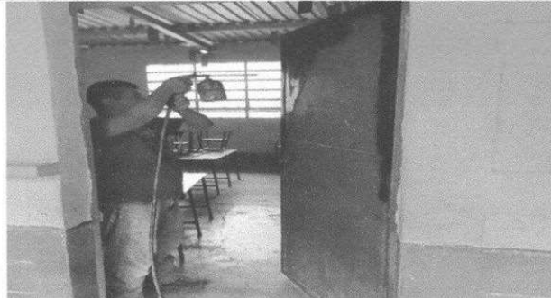
Foto 2: Mantenimiento colocación de chapas y pintada de las puertas
