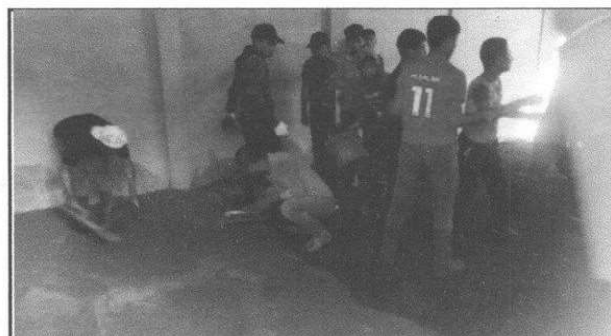
Foto 4: Fundición de piso del modulo 4
