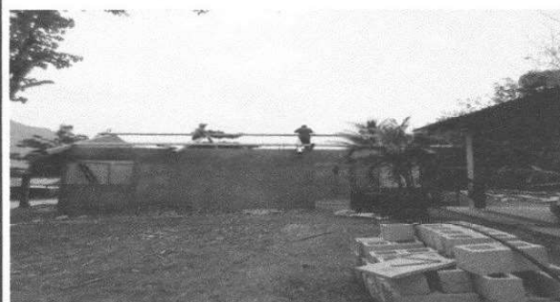
Foto 5: Colocación de costaneras del modulo 4
