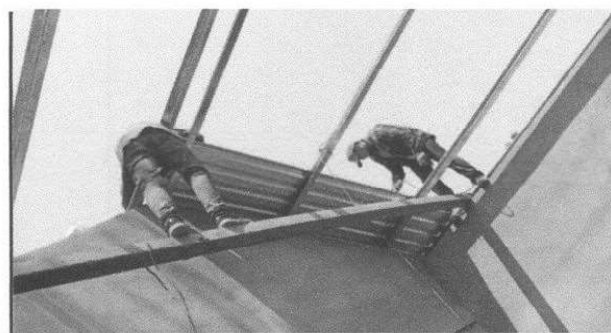
Foto 6: Colocación de láminas del modulo 4
