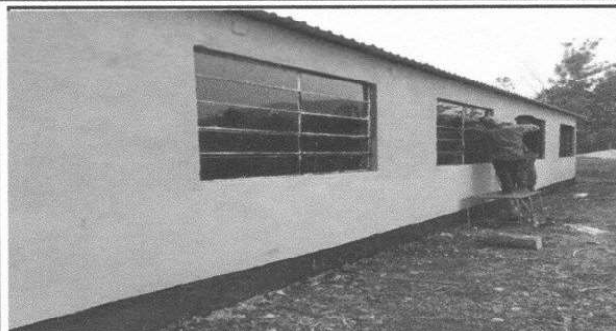
Foto1: Durante la instalacion de las ventanas del modulo 3
